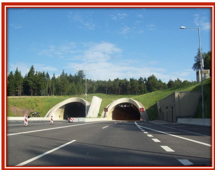
Obrázek 1 - Ilustrační foto, tunel dálnice D8; Zdroj: commons.wikimedia.org
